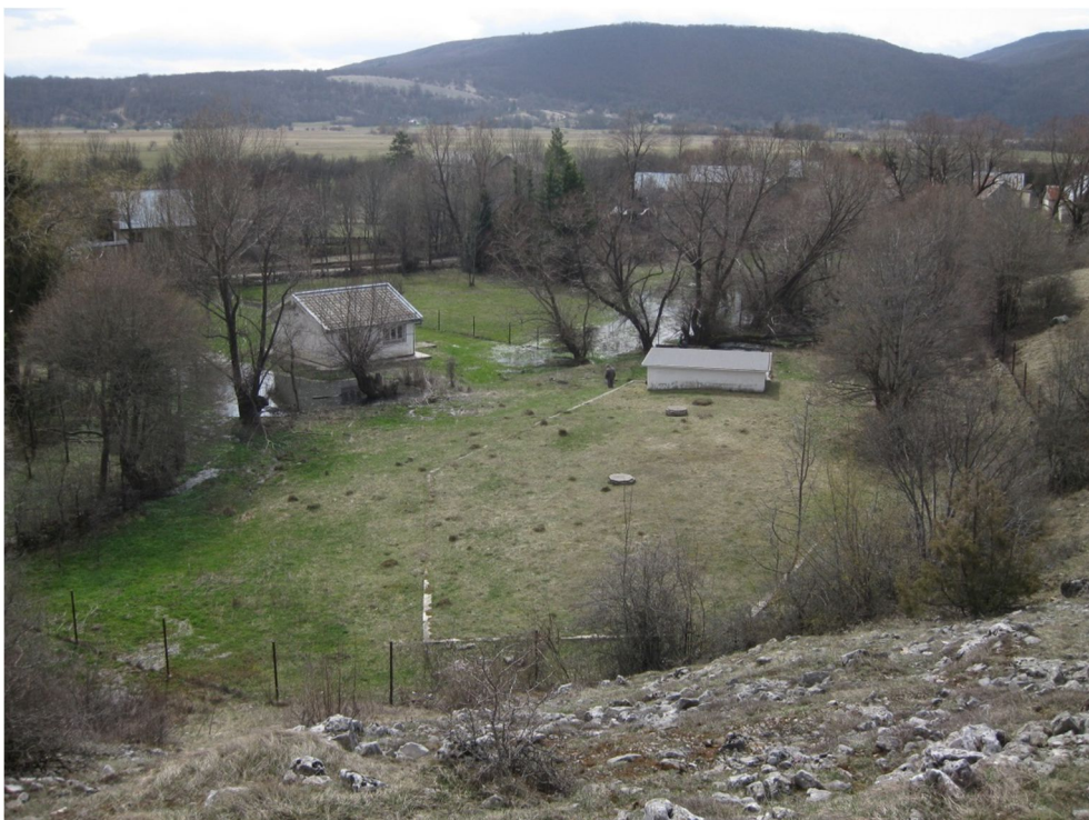
Slika 3. Kaptaza „Krbavica“, vidljivi betonski otvori u glavnu komoru kaptaze
